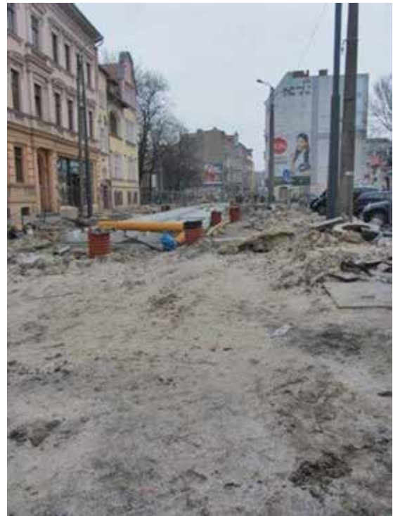
Gorzów/Landsberg baut in der ganzen Stadt
