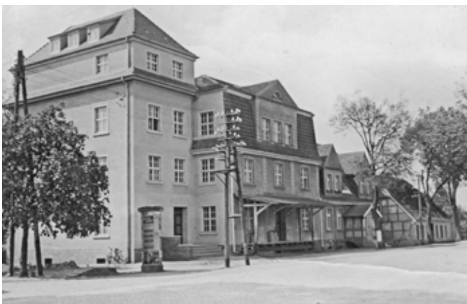
Hauptstraße 1-2: neuer Speicher mit Mühle, Wohnhaus, altes Bauernhaus (=Kate)
