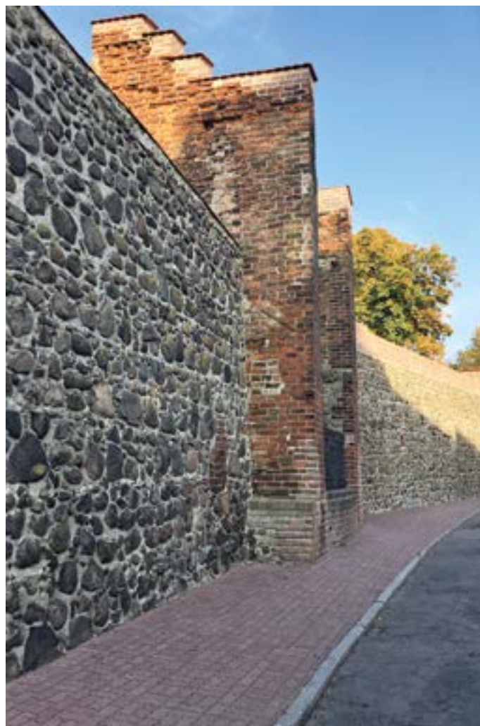
Ein Teil der restaurierten Stadtmauer.
