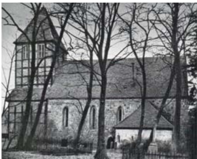
Die Kirche in Marwitz mit Turm in Fachwerkbauweise – Ansicht von Süden.
