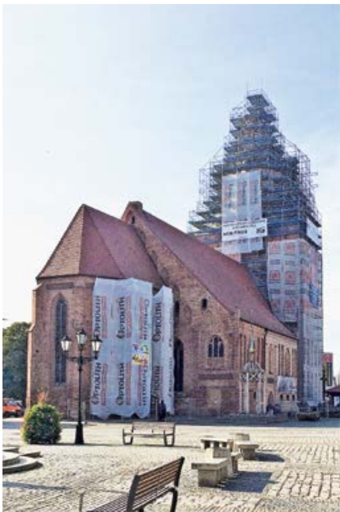
Die Marienkirche mit Baugerüst.
