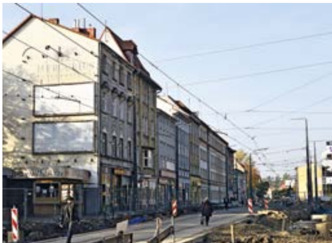
Überall in der Stadt wird gebaut – hier in der Richtstraße.
