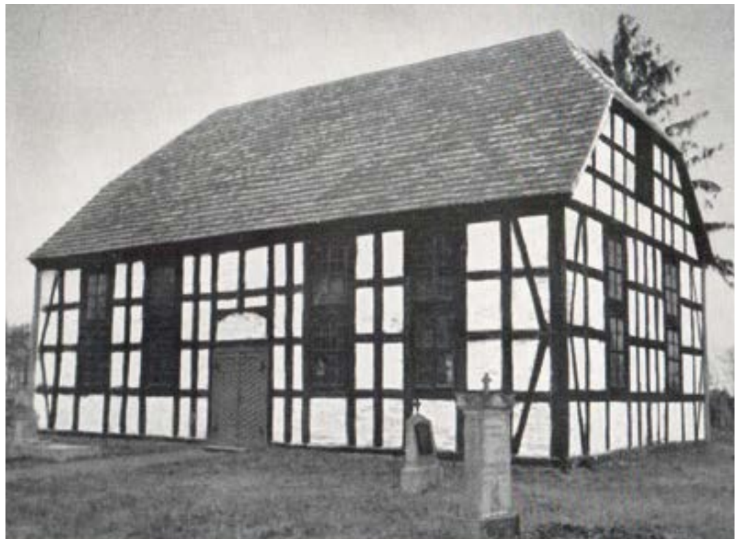
Die Kirche in Alexandersdorf ohne Turm – Ansicht von Südosten.
